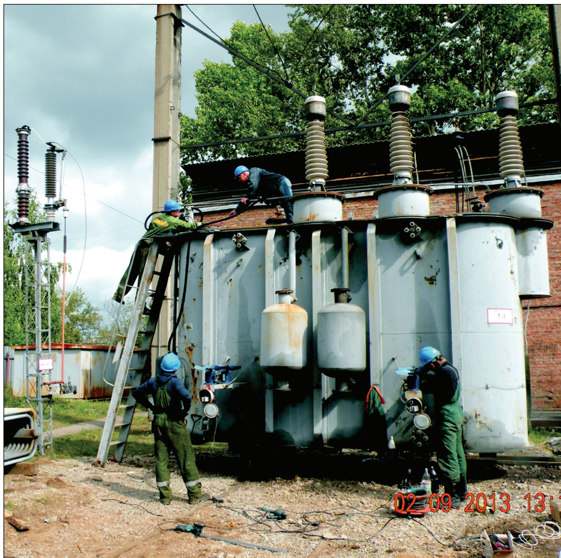
Рис. 12. Ремонт трансформатора 110/10 кВ ИНЦ СО РАН
