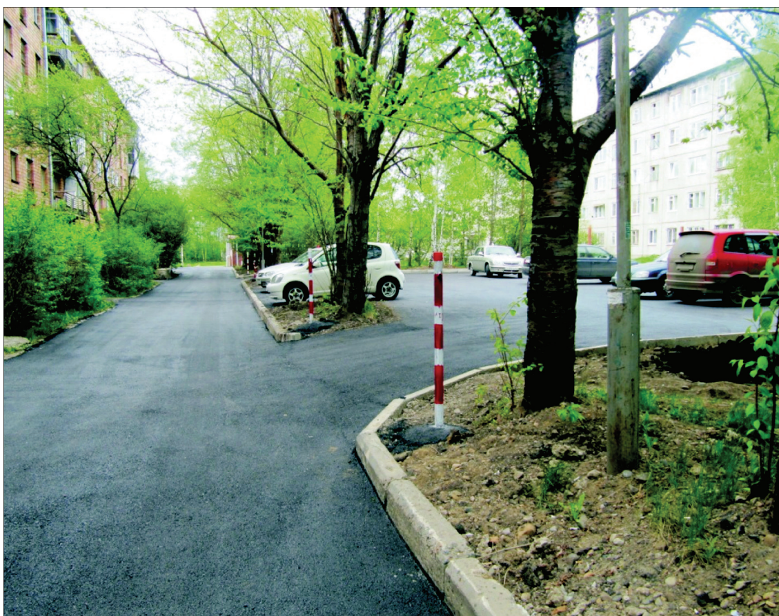
Рис. 10. Благоустройство придомовой территории с устройством парковочной площадки
