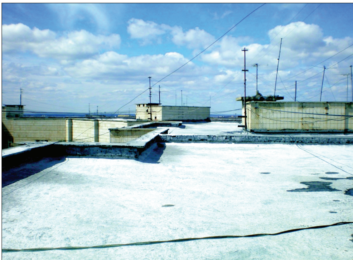
Рис. 9. Ремонт кровли многоквартирного дома по технологии сплошной заливки мастичным материалом (наливная кровля)
