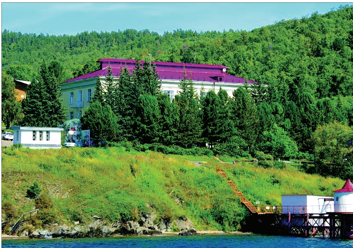
Рис. 5. Байкальский музей после ремонта кровли и фасада
