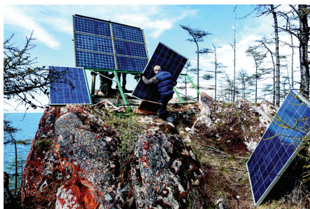
Монтаж панелей солнечной батареи
